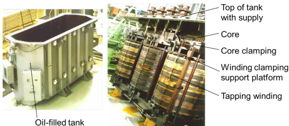
Abb. 8: Aufbau eines Leistungstransformators
